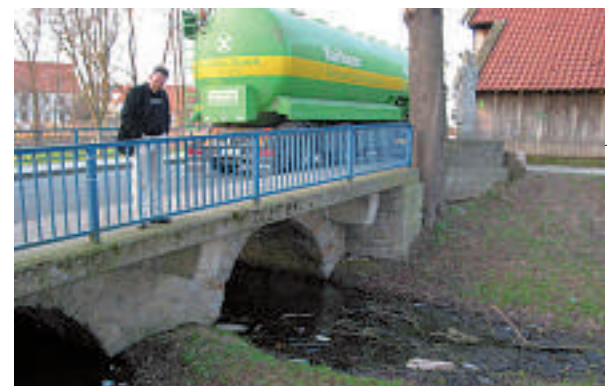
▲ Blick auf die südliche Brückenkonstruktion vor dem Rückbau (2004) Fotos: Turk
