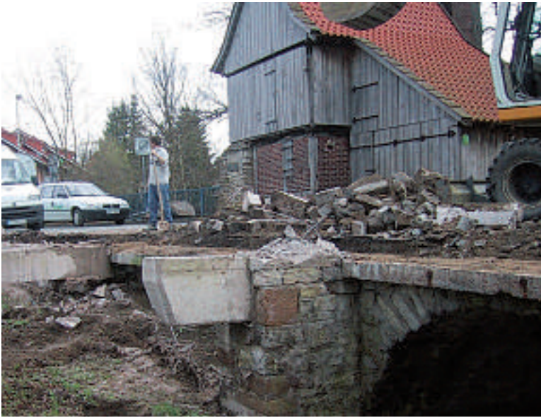
▲ Freilegung der Stahlbeton-Querriegel und der seitlichen Stahlbeton-Auflager
