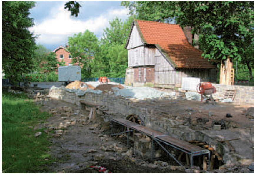
▲ Entfernung des Fahrbahnbelags und Reparatur/Neuaufbau Bruchstein-Mauerwerk
