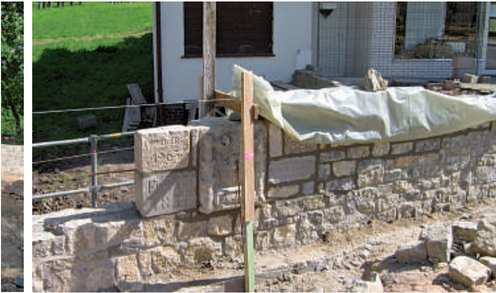
▲ Neuaufbau Brüstungsmauerwerk mit Sockel für Nepomuk-Statue
