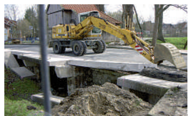
▲ Blick auf die nördliche Seite vor dem Rückbau ▼ Rückbau der seitlichen Stahlbetonkappen (2006)
